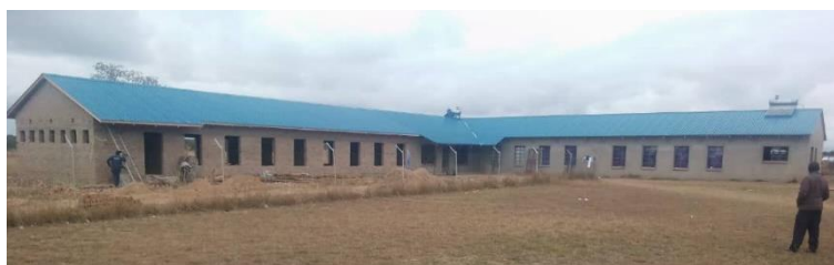
Neues Internat im Bau
